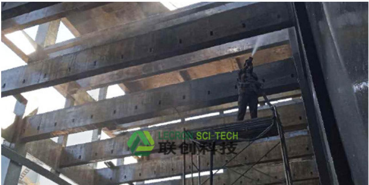
在聚脲防腐施工中，为了提高反应活性，必须加入催化剂，催化剂在催化羟基与异氰酸酯反应的同时也催化异氰酸酯与水发生反应，产生气，导致材料性能急剧下降；聚脲防腐施工则完全不同，它使用了端胺基聚醚和胺扩链剂作为活性氢组分，与异氰酸酯组分的反应活性极高，无须任何催化剂，即可在室温（甚至0℃以下）瞬间完成反应。1、聚脲防腐施工不含催化剂，快速固化，可在任意曲面、斜面及垂直面上喷涂成型，无流挂现象，5s凝胶，1min即可达到步行强度。2、聚脲防腐施工对水分、湿气不敏感，施工时不受环境温度、湿度的影响。3、固含量，聚脲防腐施工不含任何挥发性有机物，VOC，对环境友好。4、具有优异的理化性能，如抗拉强度、伸长率、柔韧性、耐磨性、耐老化、防腐蚀等。5、聚脲防腐施工具有良好的热稳定性，可在120℃下长期使用，可承受150℃的短时热作用。针对聚脲防腐施工特点联创科技就为大家介绍到这里了，如果您想的了解这方面的内容请继续关注我们的网站，我们会为您进行详细的解答。联创科技努力提高产品质量加大产品开发力度。东营音响防护聚脲施工
